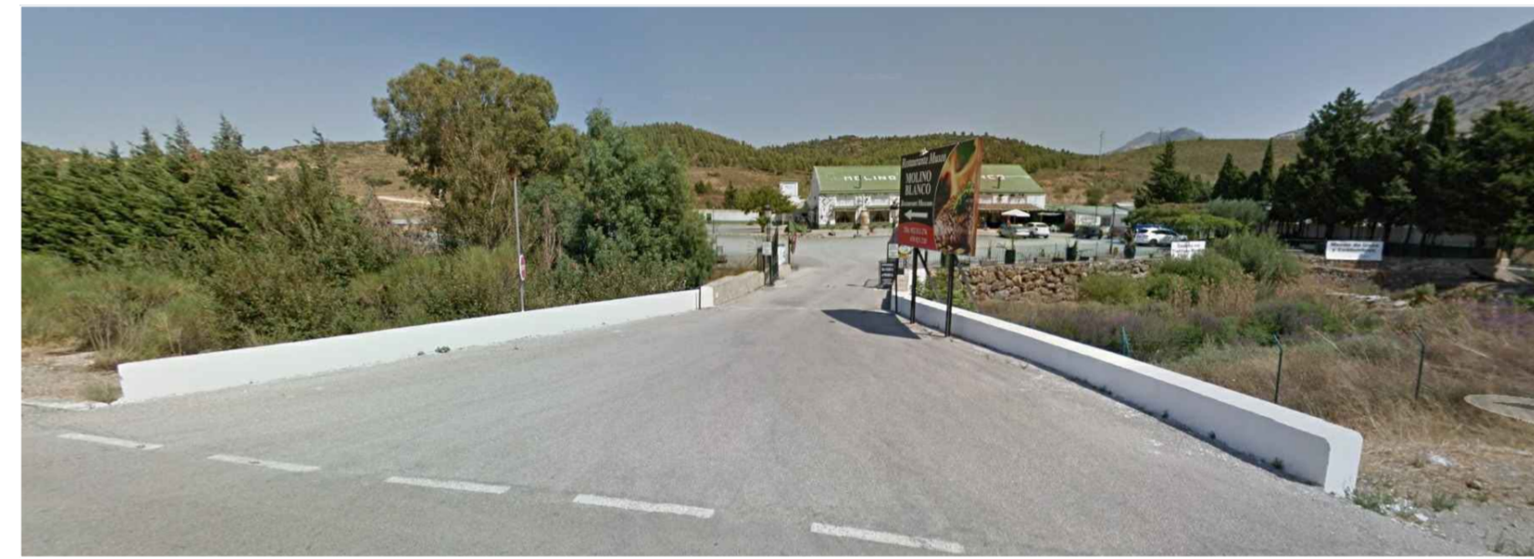
FOTOGRAFIA DEL ACCESO. ESTADO ACTUAL
