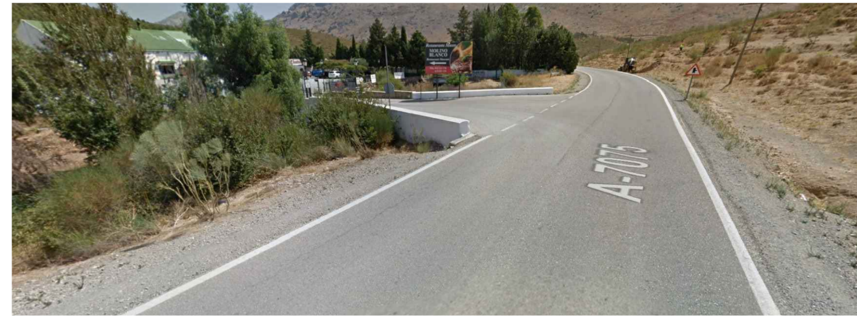
FOTOGRAFIA DEL ACCESO. ESTADO ACTUAL
