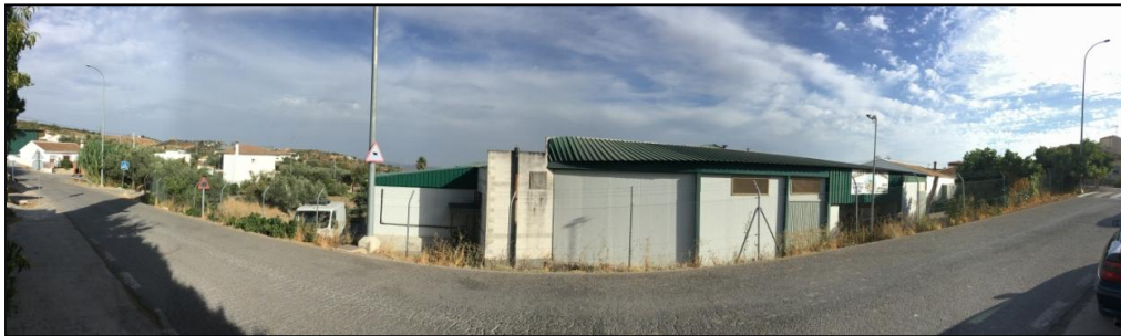
Panorámica y distintas vistas del exterior de la fábrica existente
