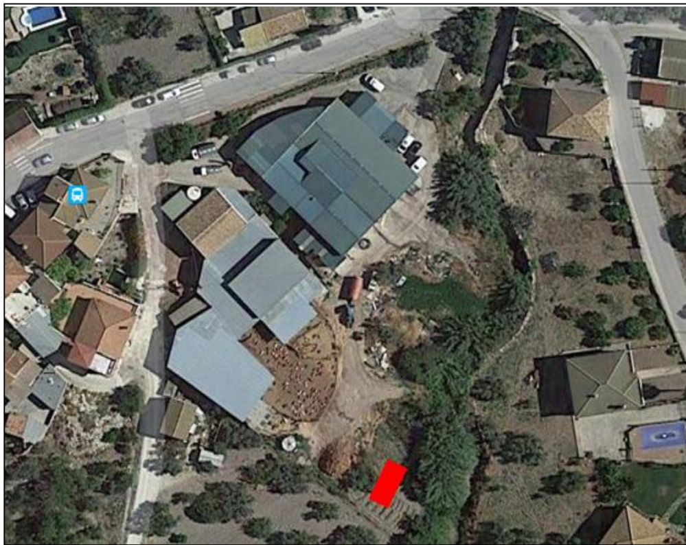
Localización prevista para la depuradora compacta prefabricada
