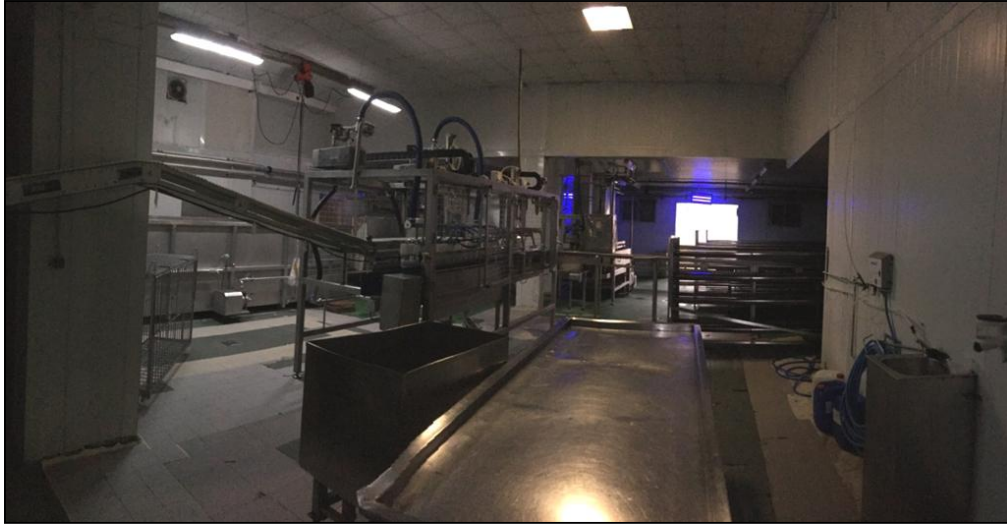
Imagen del interior de la fábrica existente
