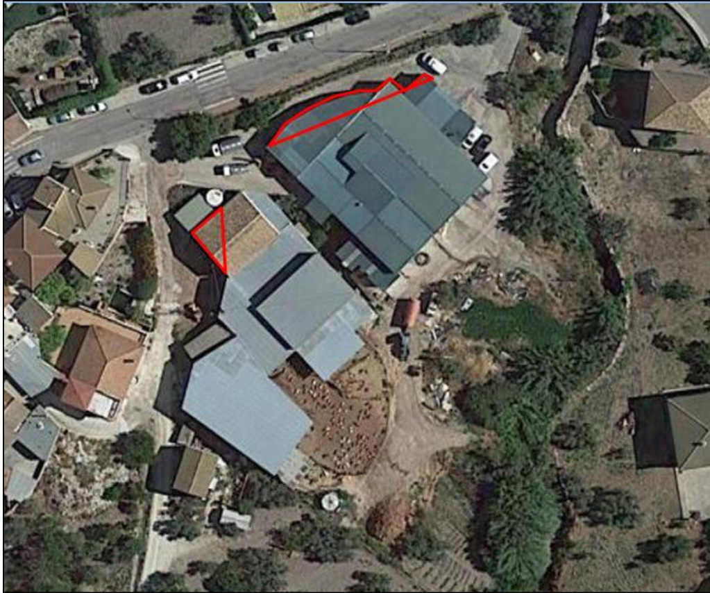
Elementos constructivos a considerar en situación de asimilado a fuera de ordenación
