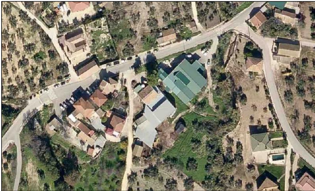
Estado de la fábrica en el año 2008
