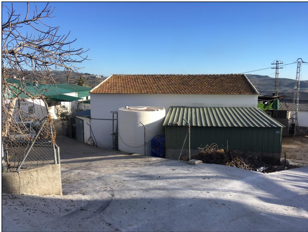
Fotografía del granero
