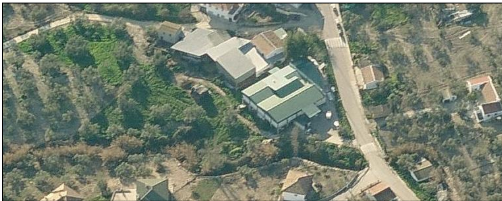
Vista aérea desde el Este de los terrenos con las edificaciones existentes
