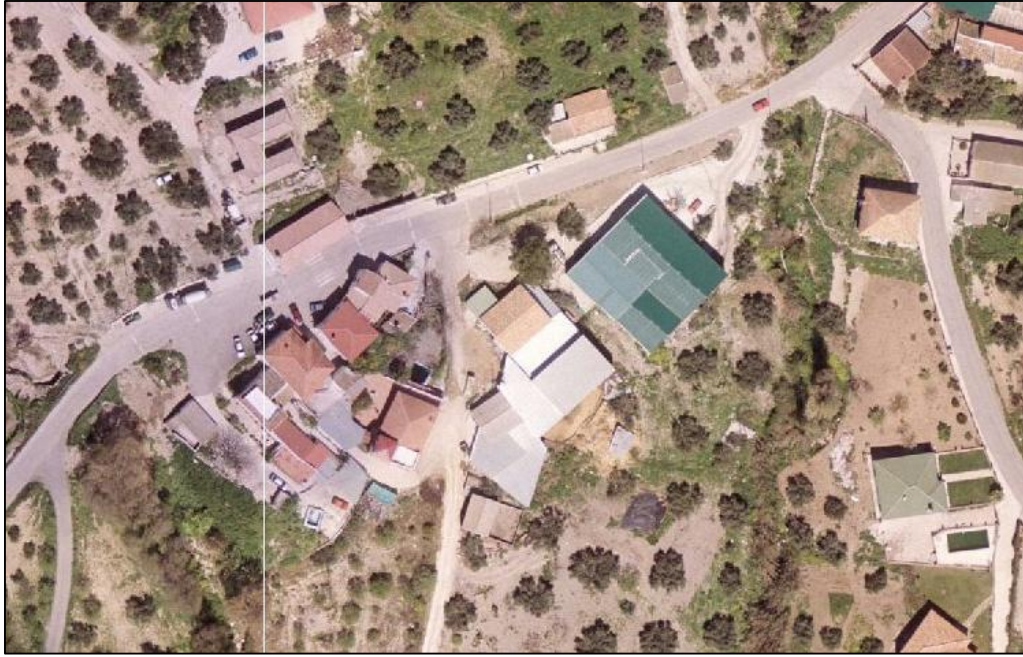
Estado de la fábrica en el año 2003
